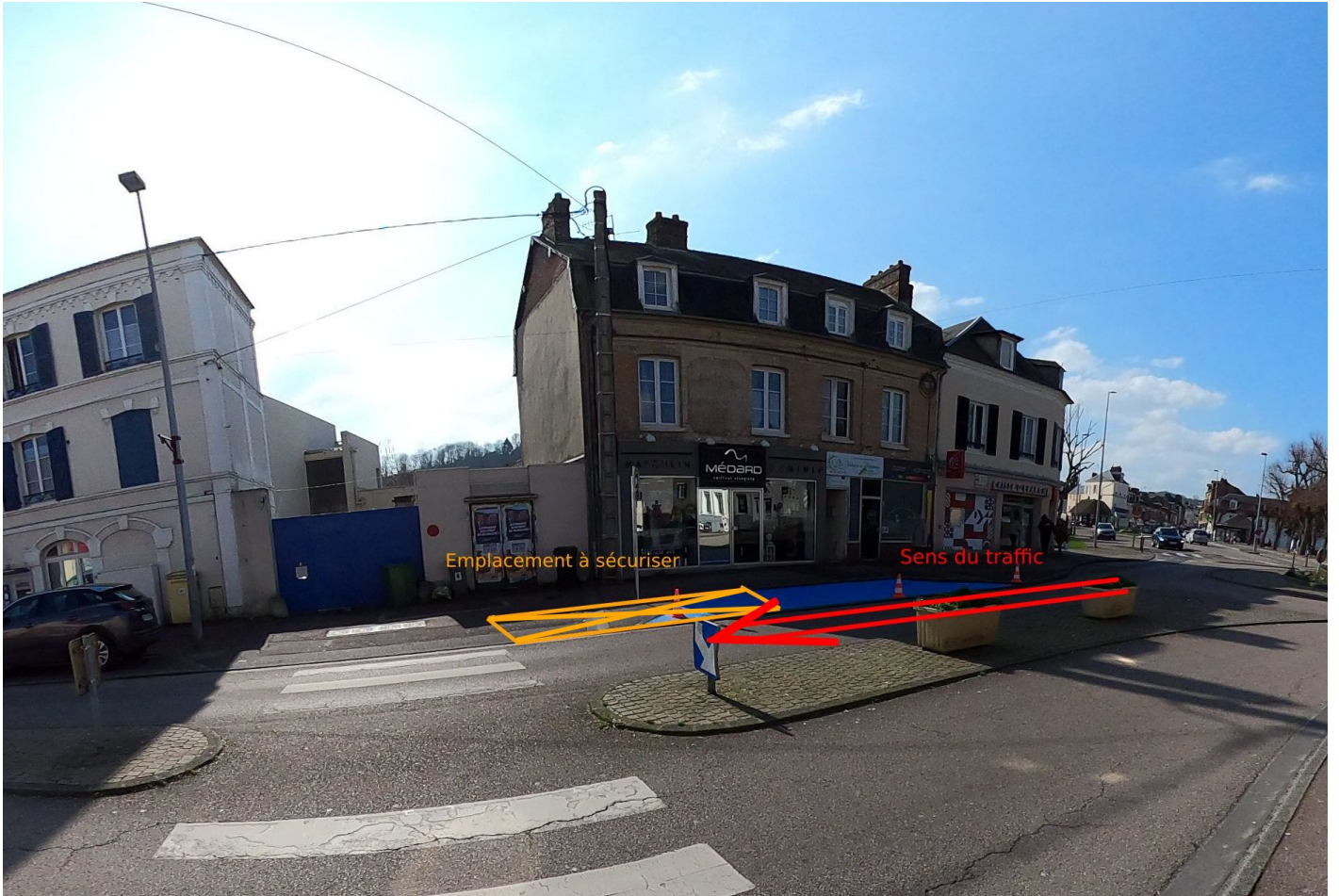
Figure 2: proposition 2 la poste (coté la poste) sur place PMR hors-norme
